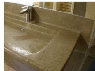
Tadelakt ist eine 2000 Jahre alte marokkanische Kalkglanzputztechnik, die für Bäder, Waschtische und an Stelle von Fliesen verwendet werden kann. Dieser Natürliche Werkstoff wird mit kalkechten Pigmenten abgetönt, einem Stein verrieben und mit Glätteseife hydrophobiert, dadurch ist er wasserfest und es ergeben sich schimmernde, lebendige Oberflächen.
